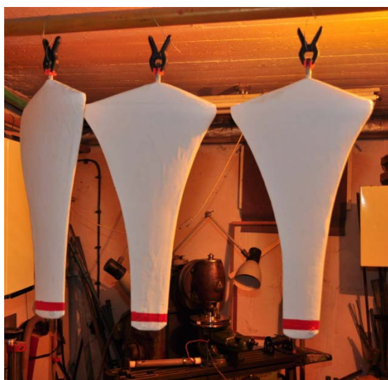
Obrázek 3.2-1: Sušení nově natřených listů při první údržbě v lednu 2012 (vlevo) a pohled na složený rotor (vpravo)
