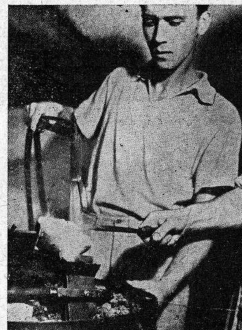
Obr. 2. Tavení dmuchavkou
