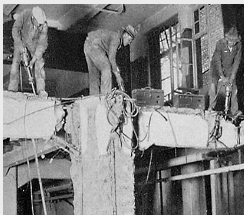
Bosch-Hämmer bei eiligen Abbrucharbeiten erfolgreich eingesetzt.
