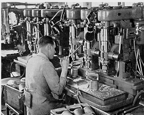
Der BOSCH-Hammer: Bohren des Motorgehäuses
