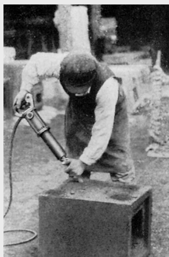
Dann wird der Kamin- stein mit dem BOSCH- Hammer ausgemei- ßelt
