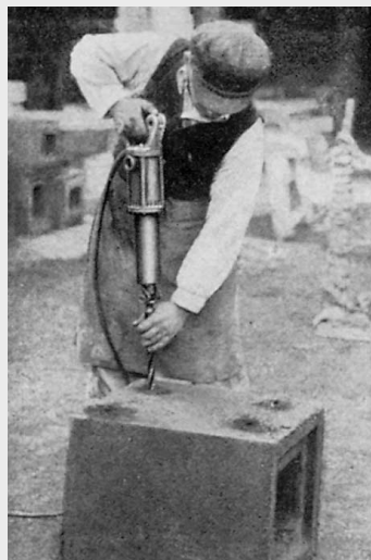
Ein Ka- minstein wird mit dem BOSCH- Hammer angebohrt
