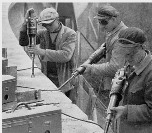
Bosch-Hämmer beim Setzen von Geländerbefestigungen
