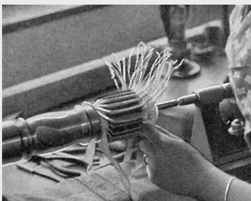
Der BOSCH-Hammer: Wickeln der Ankerspulen
